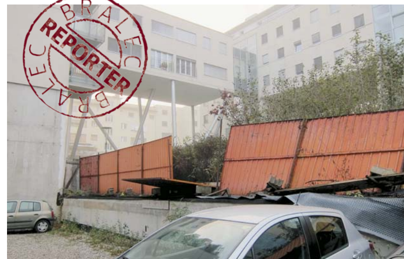
Del gradbene ograje, ki vztraja še enajst let po koncu gradnje, je močan veter v nedeljo znova prevrnil.
